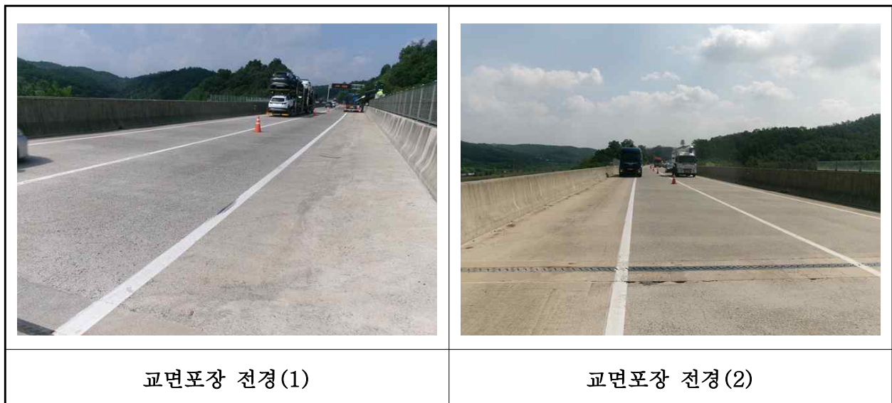
【사진 27.3.20】 교면포장 전경
