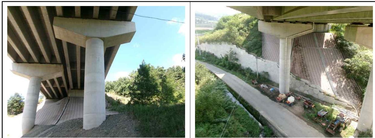
교각 코핑부 상태양호
