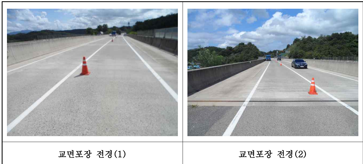
【사진 27.3.47】 교면포장 전경
