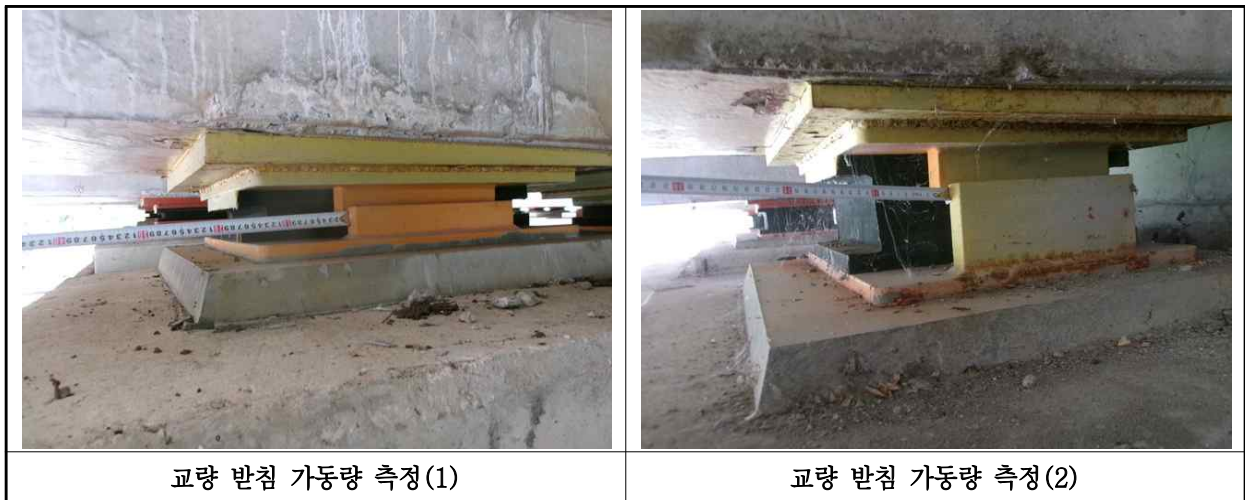
【사진 27.3.43】 교량받침 이동량 측정
