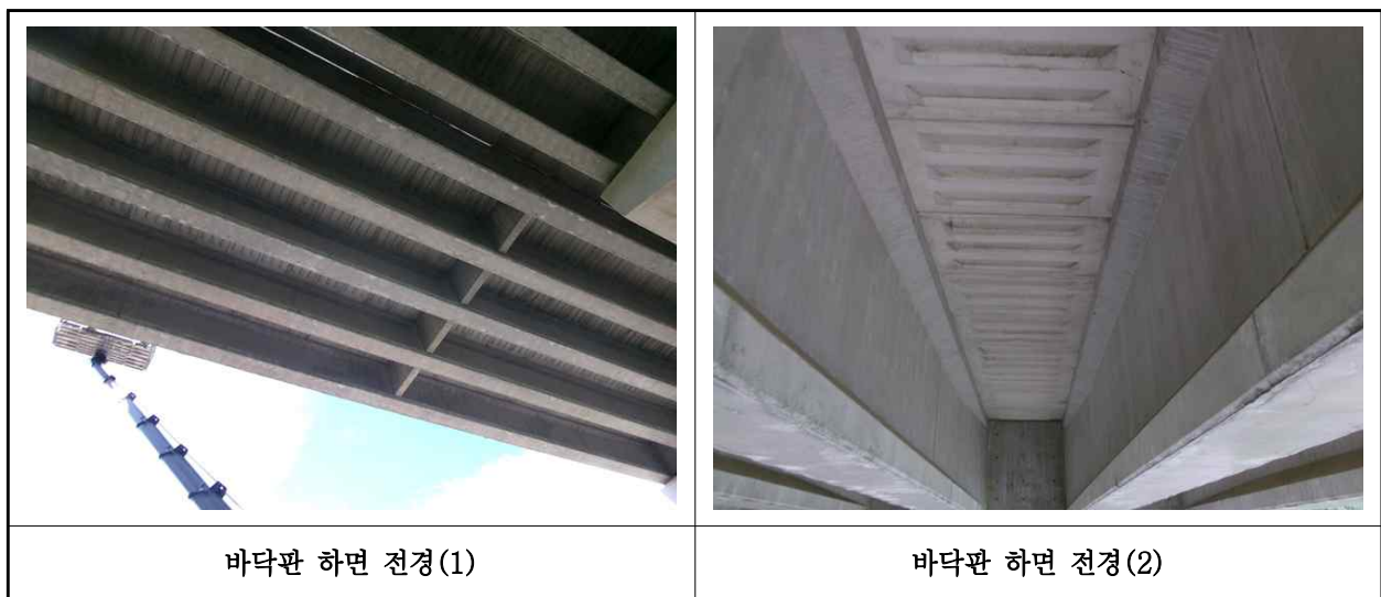
【사진 27.3.29】 바닥판하면 전경
