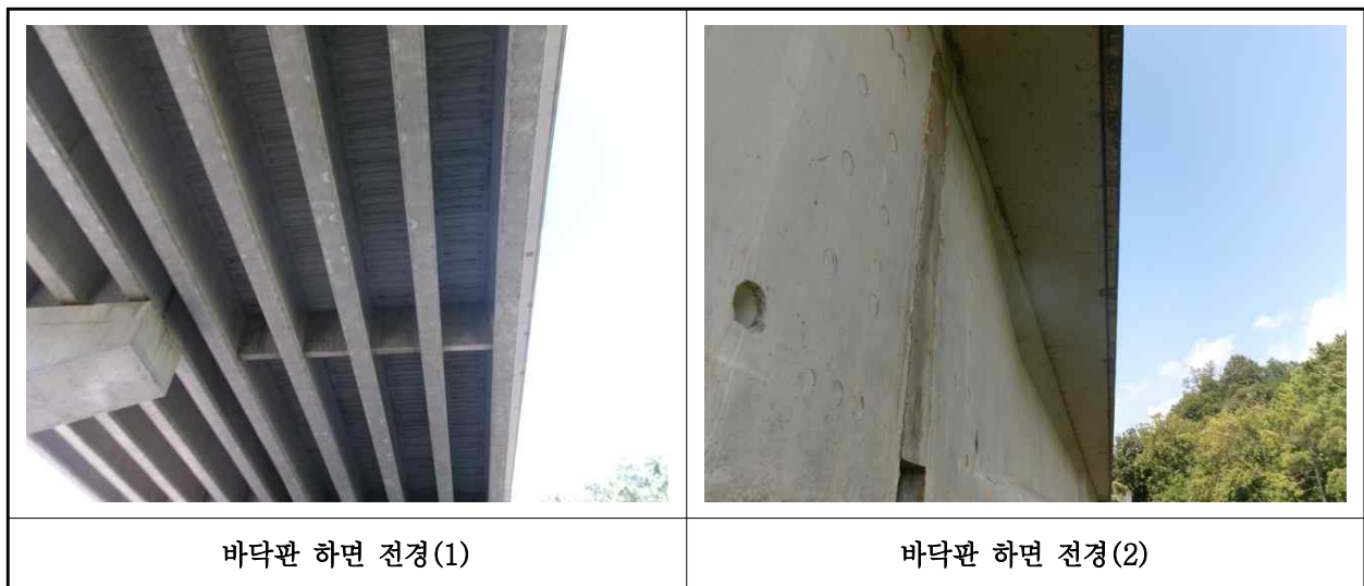
【사진 27.3.2】 바닥판하면 전경
