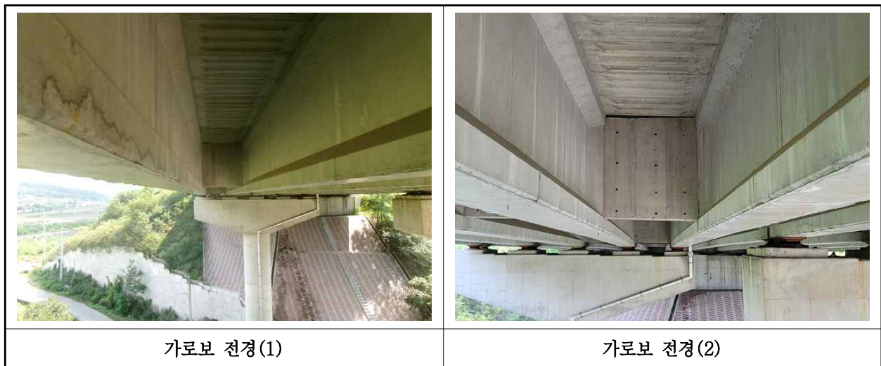
【사진 27.3.6】 가로보 전경
