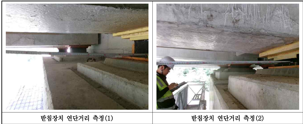
【사진 27.3.42】 교량받침장치 연단거리측정
