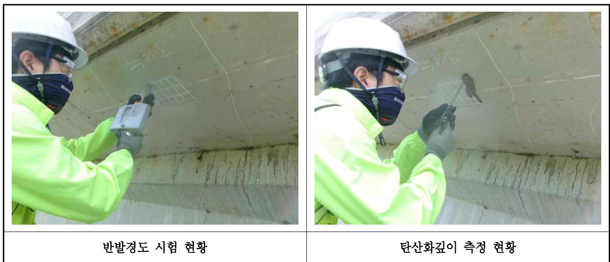
【사진 27.4.1】 콘크리트 내구성조사 현황
