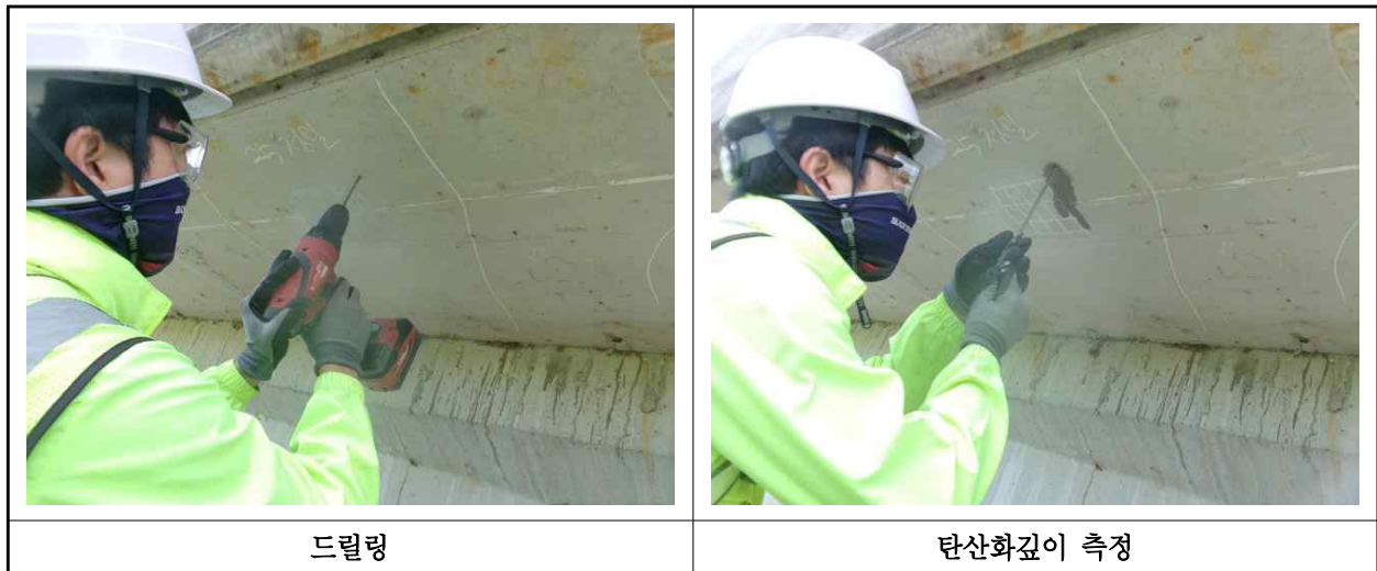
【사진 27.4.3】 탄산화 깊이 측정 현장사진
