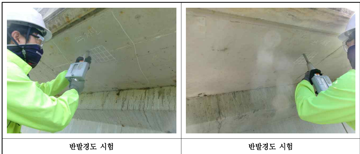
【사진 27.4.2】 반발경도시험 현장사진
