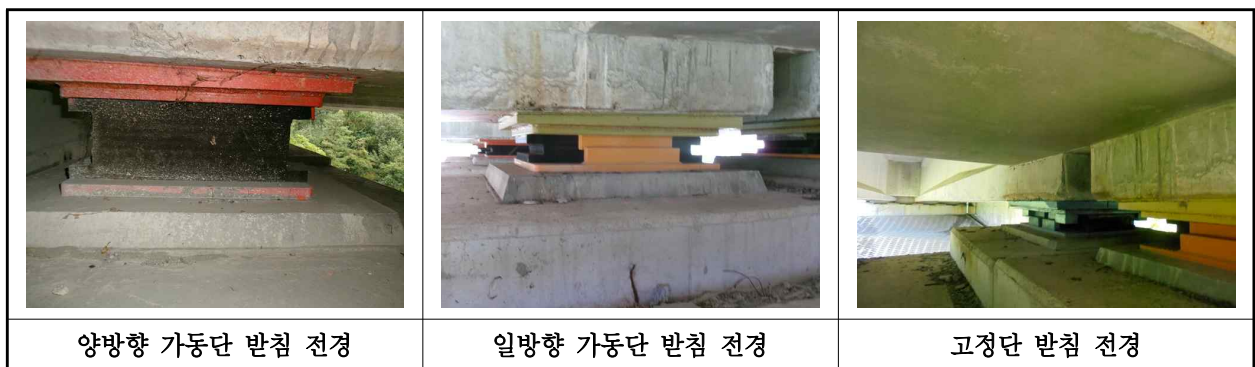
【사진 27.3.13】 교량받침 전경
