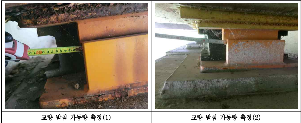
【사진 27.3.16】 교량받침 이동량 측정
