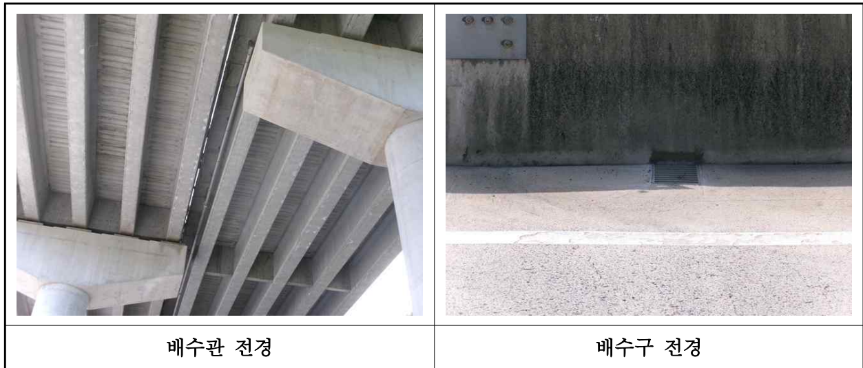
【사진 27.3.22】 배수시설 전경
