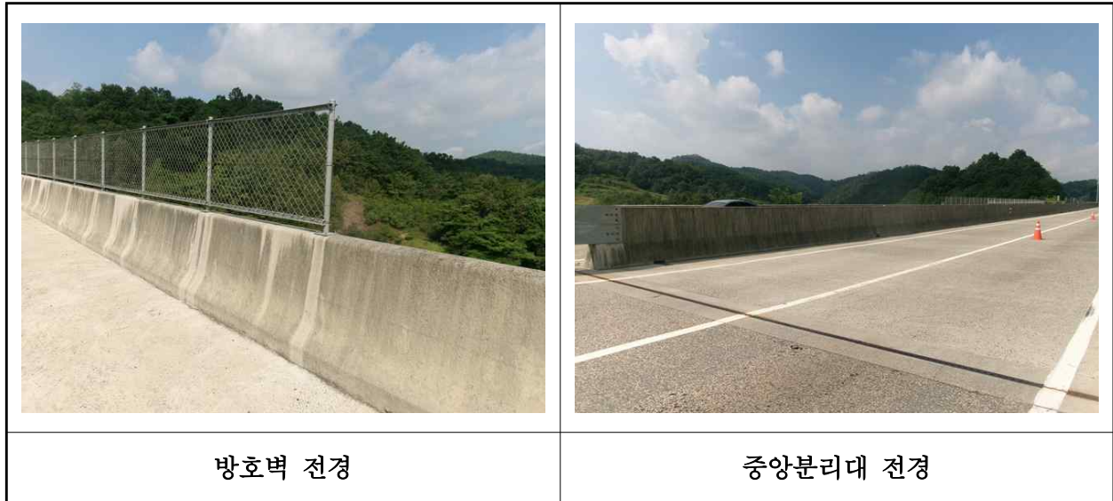
【사진 27.3.24】 방호벽 및 중앙분리대 전경
