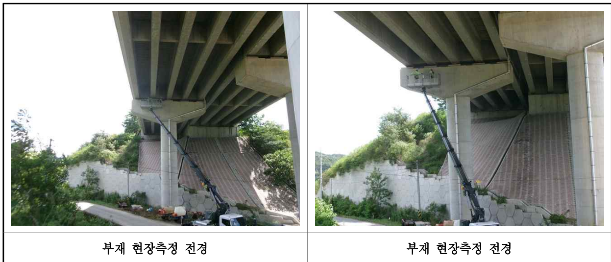
【사진 27.2.1】 부재 현장측정 전경
