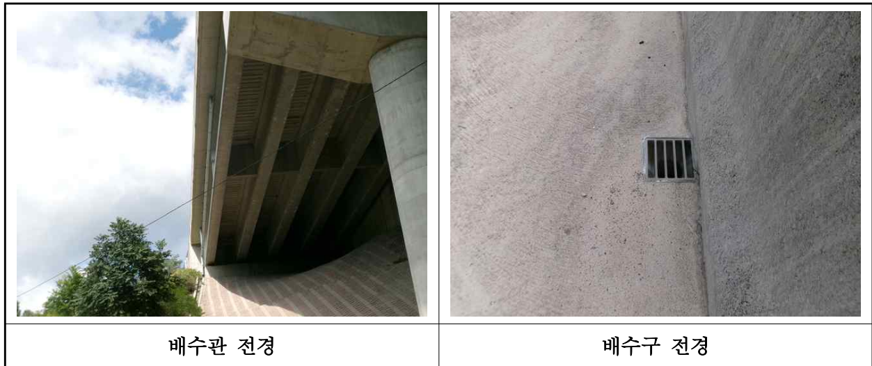
【사진 27.3.49】 배수시설 전경
