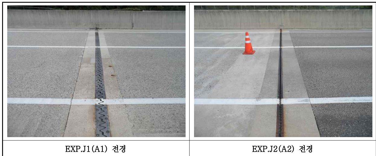
【사진 27.3.44】 신축이음장치 전경
