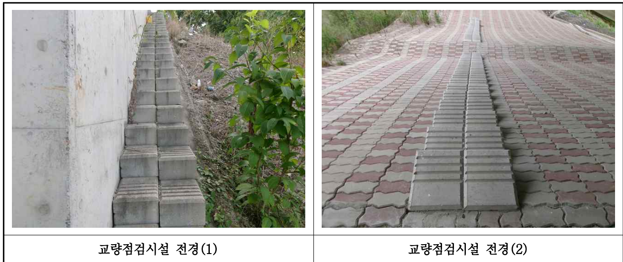
【사진 27.3.26】 교량 점검시설 전경
