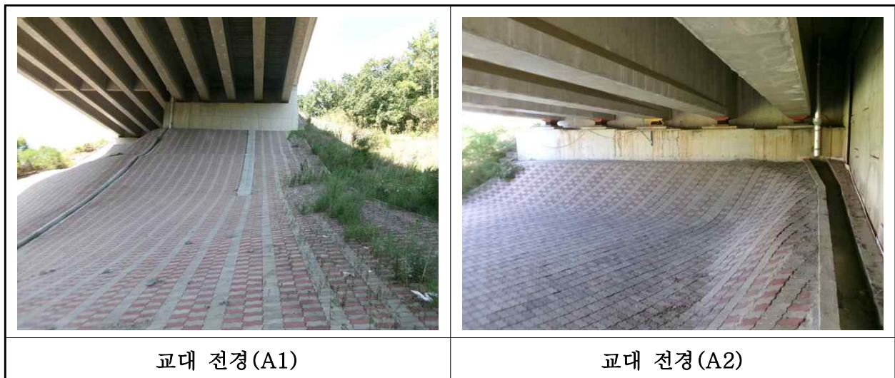
【사진 27.3.8】 교대 전경
