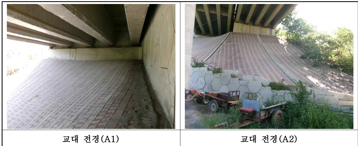
【사진 27.3.35】 교대 전경
