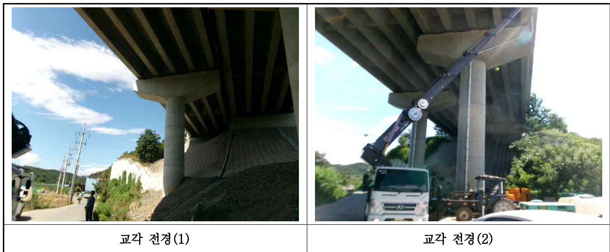
【사진 27.3.37】 교각 전경
