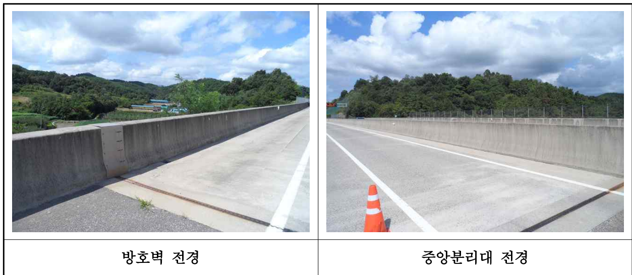
【사진 27.3.51】 방호벽 및 중앙분리대 전경
